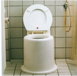
Vakuumtoilette, um den Wasserverbrauch auf der Station zu vermindern. Hier werden, ähnlich wie bei modernen Zügen oder Schiffen, pro Spülgang nur etwa 1,3 Liter Wasser verbraucht.
